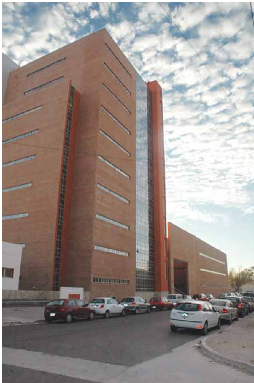
Vista exterior del Edificio.
