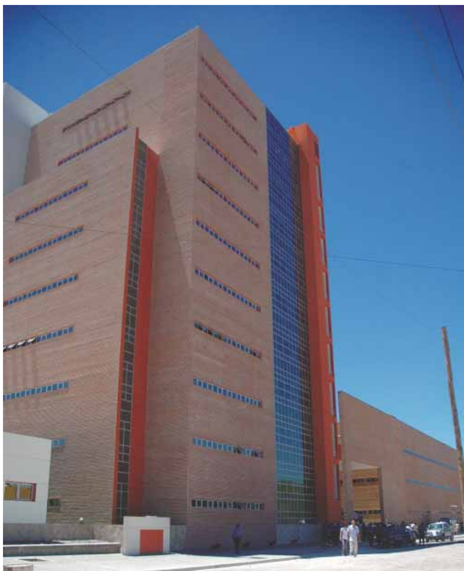
Vista exterior del Edificio.
