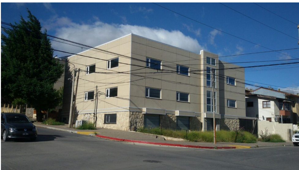
Bariloche: Edificio Anasagasti y Goedecke, destinado a las fiscalías.
