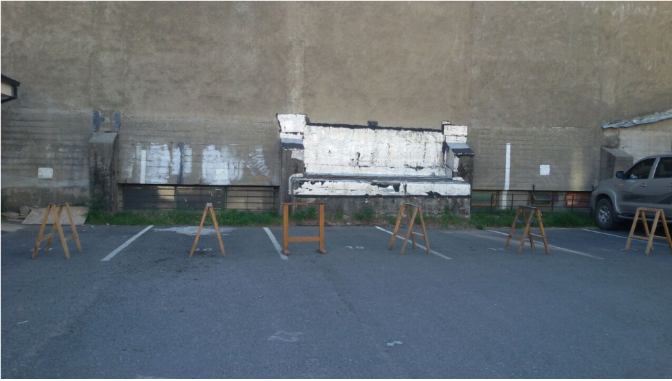
Bariloche: trabajos para instalar el shelter
